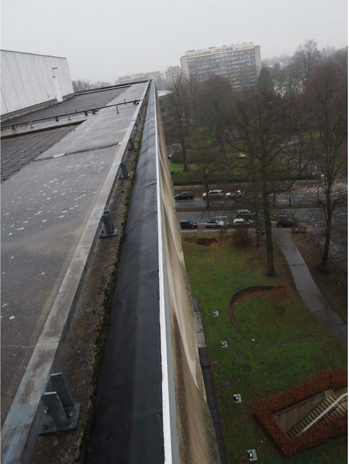
Figure 18. Vue de l'arrête du toit du bâtiment CBR.
