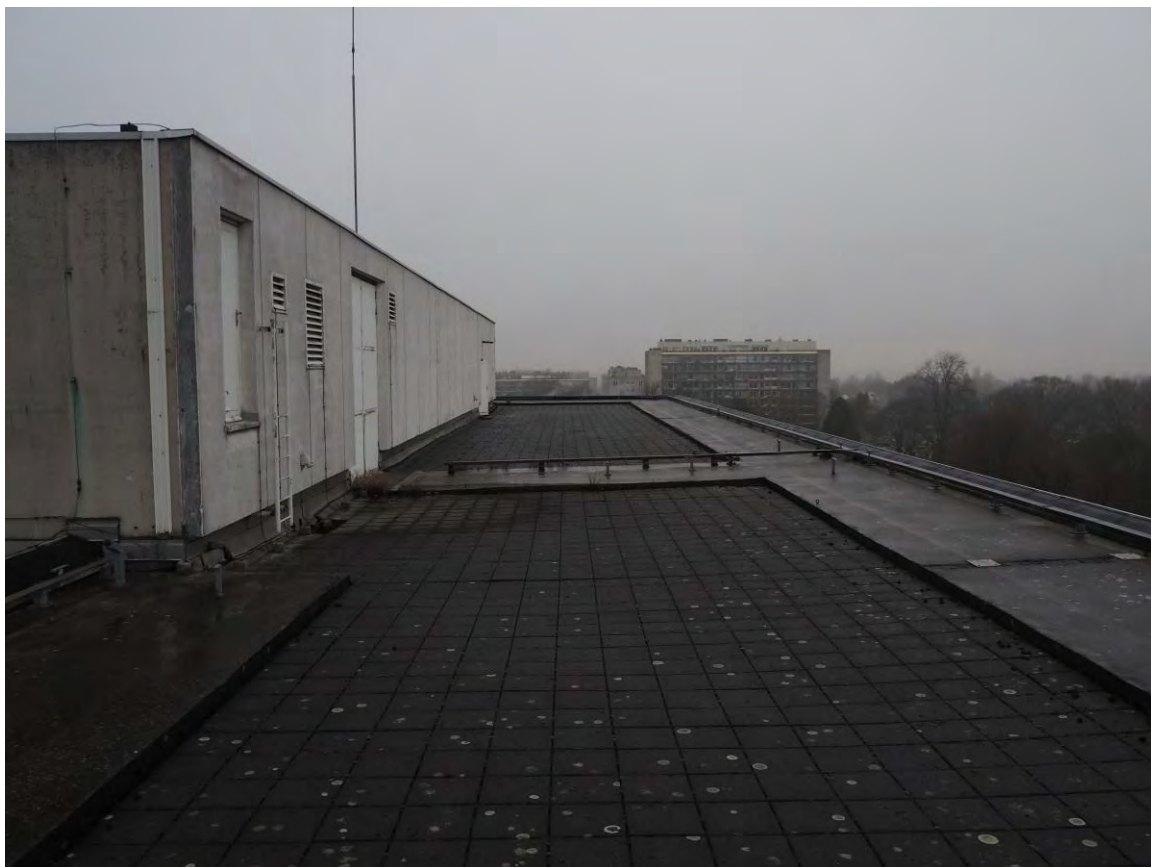
Figure 17. Vue de l'étage technique et du toit plat de l'immeuble CBR.
